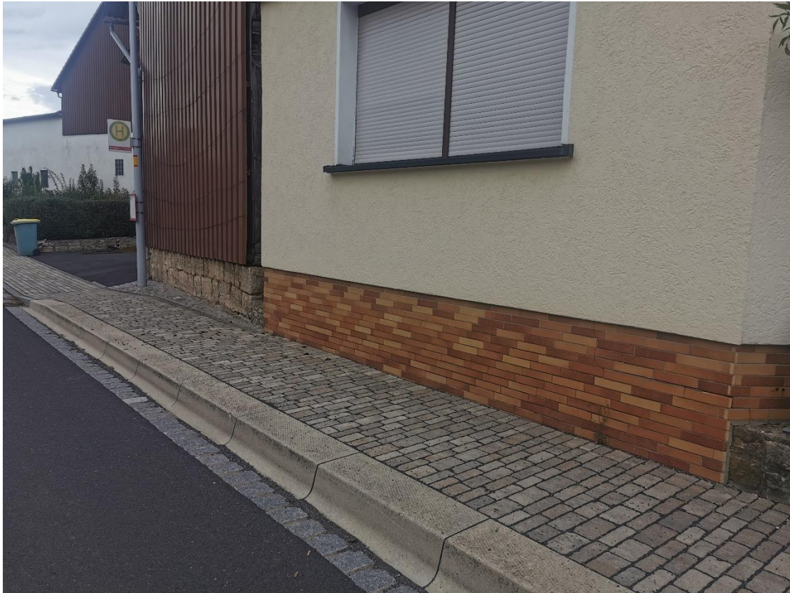
Abbildung 38: Beispiel für ausgebaut Haltestelle mit Nichterfüllung der Anforderungen an die vollständige Barrierefreiheit (Haltestelle Ahlstadt)
