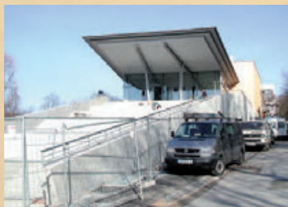
Das Utopolis entsteht – Januar 2000
