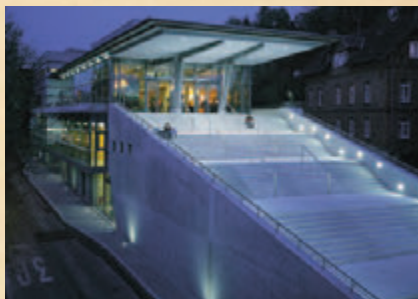
2001: Das Utopolis ist fertig
