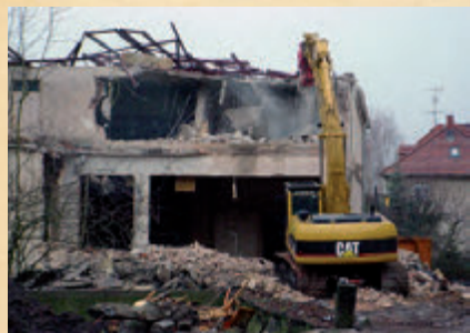
2004: Das Casino wird abgerissen
