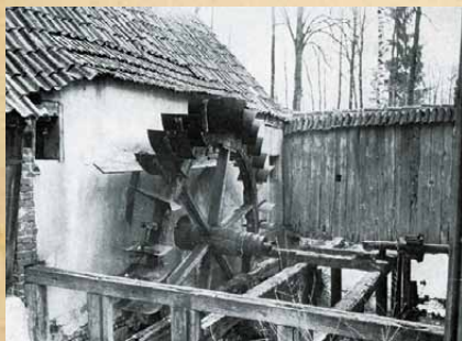
Das Wasserrad der Märbelmühle von Oberlauter, das die beiden Mahlgänge antrieb (Zustand 1965). Diese letzte Märbelmühle des Coburger Landes ist inzwischen abgebrochen worden.
