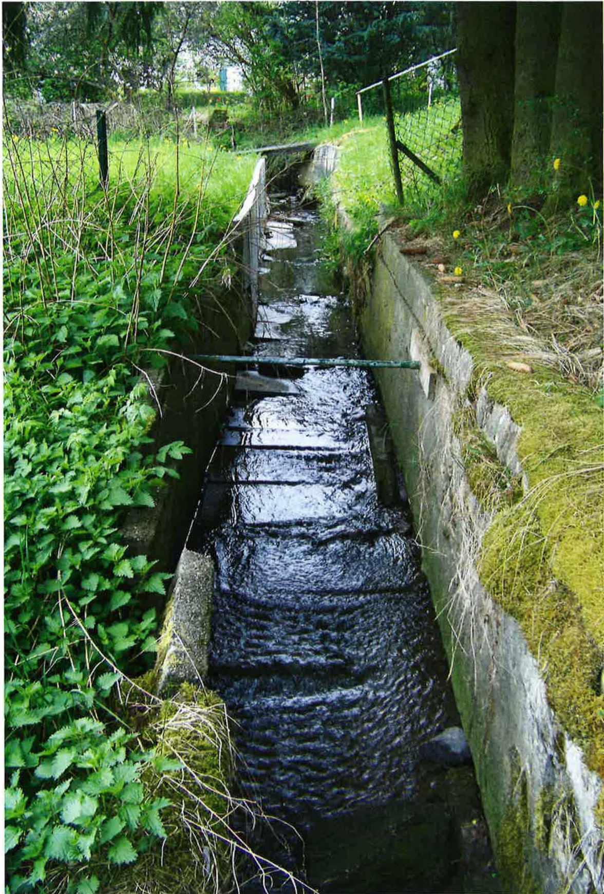
Abbildung 1: Geschlossener Ufer- und Sohlverbau am Rottenbach
