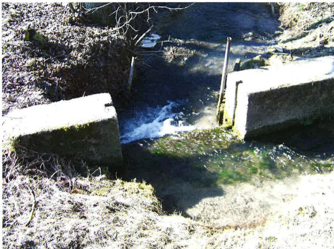
Abbildung 6: Nicht mehr genutztes Querbauwerk am Ketschenbach
