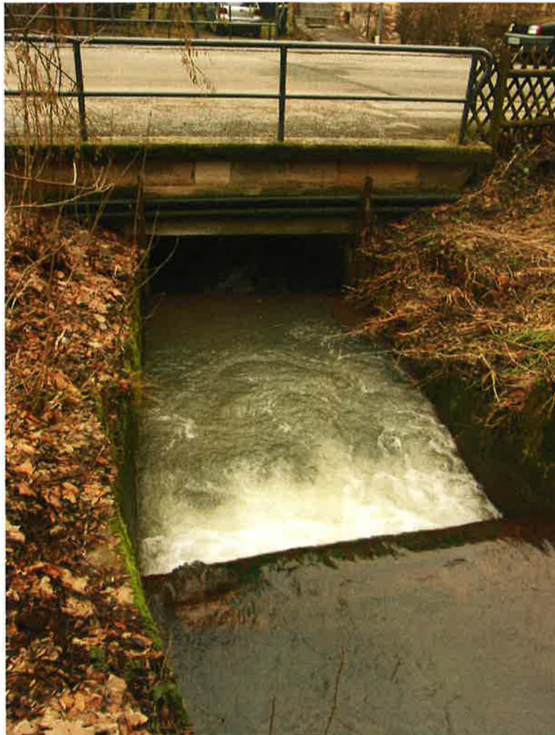
Abbildung 8: Absturztreppe am Ketschenbach
