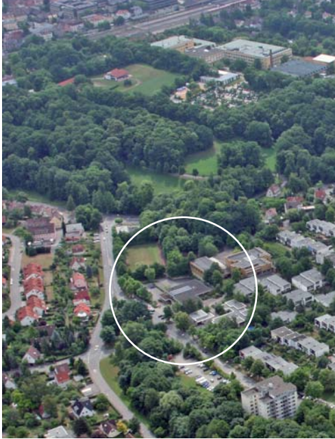
Abb. 6.8 EKZ Hörnleinsgrund im Wohngebiet DEMO, mit der Schließung des Lebensmittlers Hörnleinsgrund steht eine wichtige Fläche leer
