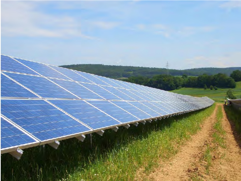
Abbildung 2: Modulgestell „3-reihig quermontiert“ kurz vor Fertigstellung
